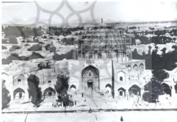
تصویر ۱۱. مرمت مسجد شیخ لطف‌الله در دوره پهلوی اول: به وضع نابه‌سامان کاشی‌های ورودی مسجد شیخ و وضعیت غرفه‌های میدان توجه شود (آرشو سازمان میراث فرهنگی و گردشگری استان اصفهان).
