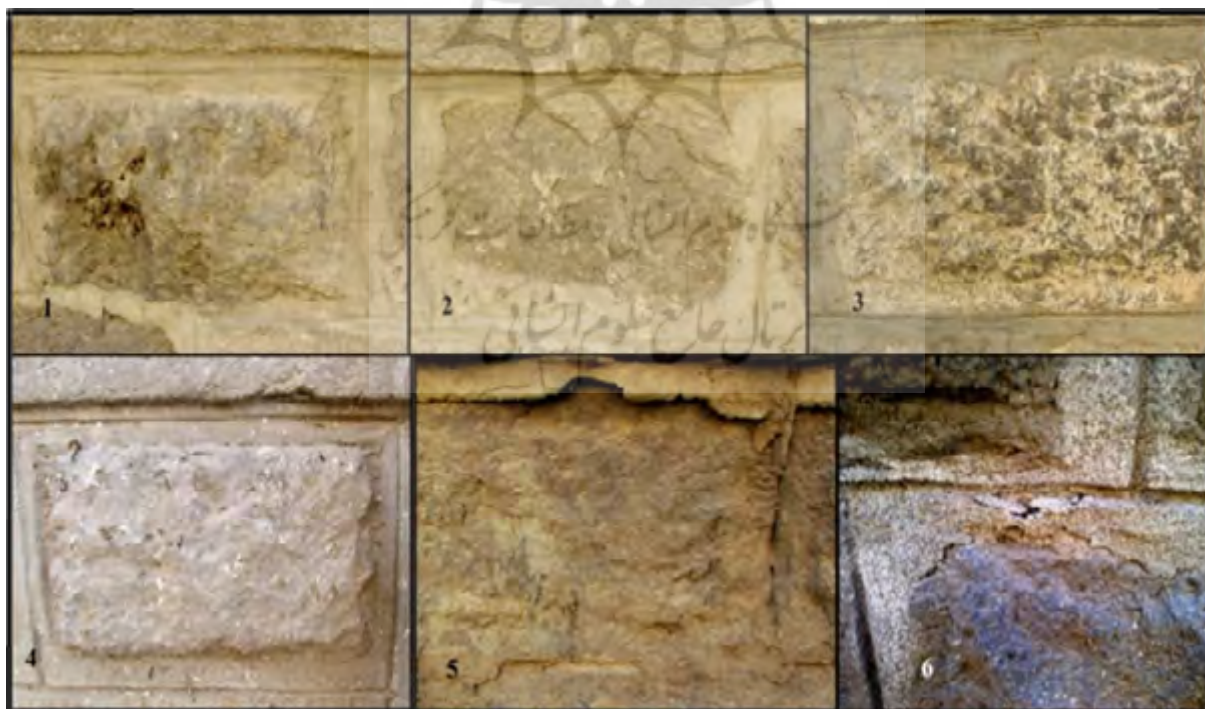
تصویر ۲. حجم بالای رسوبات محیطی و فضولات بر سطح سنگ‌ها (شماره‌های ۴ و ۵) و استفاده از ملات ماسه سیمان موجب از دست رفتن بخش‌هایی از سنگ‌ها ۱، تورق سطح سنگ‌ها ۲، خورده شدن مغز سنگ‌ها و باقی ماندن ملات تخریب کننده ۵ و در نهایت تاول و پوسته شده. ملات بر اثر نمانشکفتگی نمک در زیر ملات ۶ شده است.
