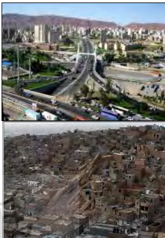
شکل ۱۰- رواج برج‌سازی و بلندمرتبه‌سازی بر روی گسل در شهرک‌های جدید احداث تبریز (بالا و پایین سمت راست)، ساختمان‌های غیراستاندارد حاشیه شهر تبریز در پای کوه‌های عون بن علی (پایین سمت چپ) (خبرگزاری مهر، ۱۳۹۰)
