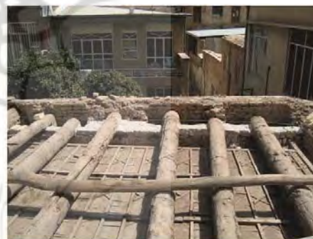
تصویر ۶: تیرهای اصلی باربر سقف و قرار گیری تیرهای فرعی بین آن ها- بهمن ۱۳۸۸
