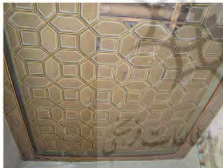
تصویر ۷: سقف کاذب چوبی زیر تیرهای اصلی- بهمن ۱۳۸۸
