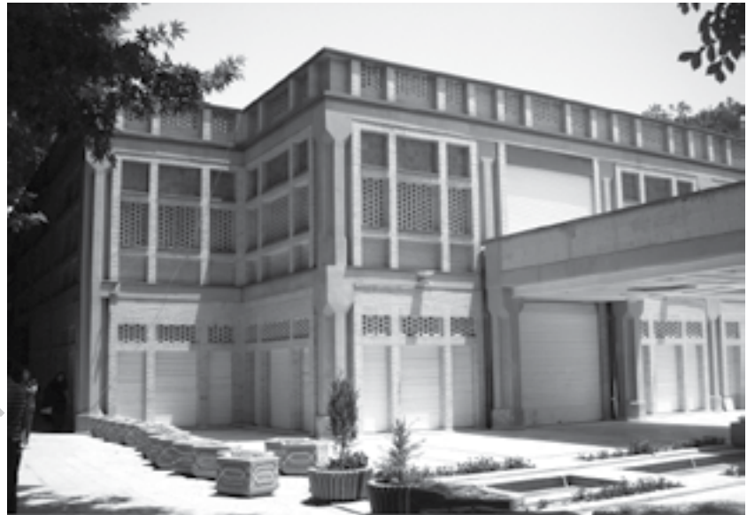
تصویر شماره ۱۱: امروزه جستجوی روش‌هایی برای استفاده از الگوهای معماری اصیل و مقاوم‌سازی آن‌ها در برابر زلزله و سایر عوامل (آسیب‌رسان ضرورت جدی دارد. (ساخت و ساز در حاشیه عمارت هشت بهشت و مجموعه چهارباغ اصفهان مأخذ: نگارنده)
