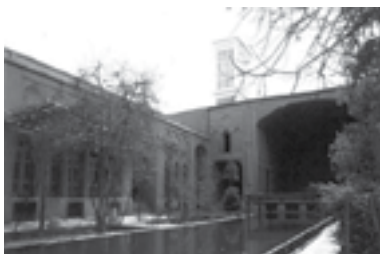
تصویر شماره ۸: جبهه‌های جنوب شرقی و جنوب غربی خانه لاری‌ها (مأخذ: کتاب گنجنامه، خانه‌های یزد)
