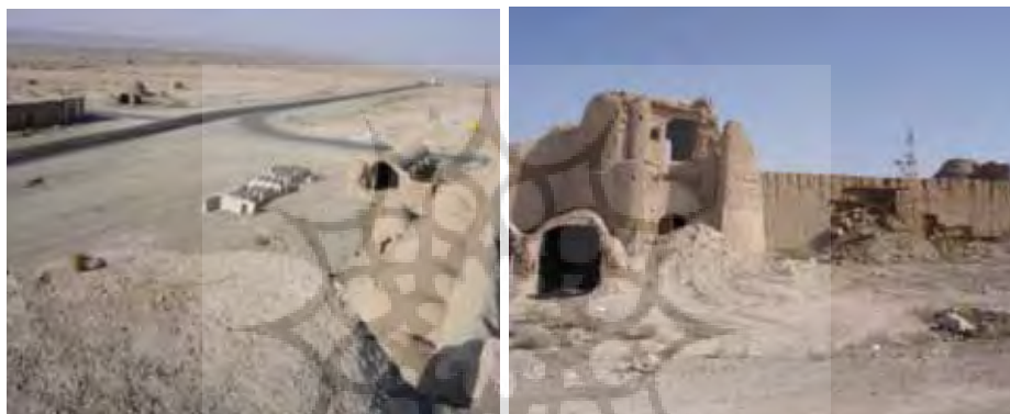
تصاویر شماره ۵ و ۶: نمای جنوبی، در ورودی بازار آب انبار دو در کاروانسرای عبدل آباد (Authors)
