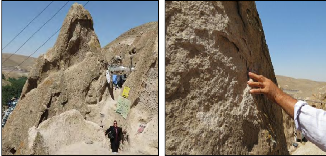
تصویر ۸۰: تصاویری از پوسته پوسته شدن سنگ و ریزش سطح خانه‌ها
