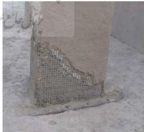
شکل ۶: تکستایل استفاده شده در زیر اندود
