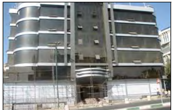
شکل ۶- استفاده از نماهای شیشه‌ای در ساختمان‌ها
