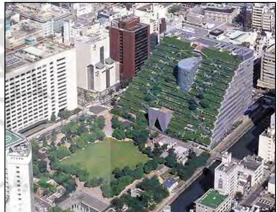
شکل ۵- ساختمان پله‌ای شکل با درختچه‌های کاشته
