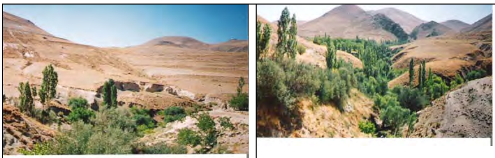
شکل ۸: (الف) تشکیل خندق عمیق و طولیل در سطح دامنه‌ها دربخش میانی حوضه آذرشهرچای و (ب) وقوع لغزش درکناره بسترجریان و ورود مواد به داخل بستر در یکی از شاخاب‌های رودخانه گنبرچای در حوضه
