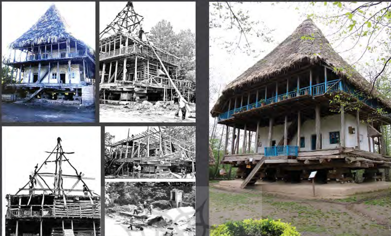
۲: مراحل جداسازی خانه رفیعی واقع در روستای رودبنه شهرستان لاهیجان و انتقال آن به موزه روستایی گیلان، مأخذ: پویا میروسی، ۱۳۸۴.
