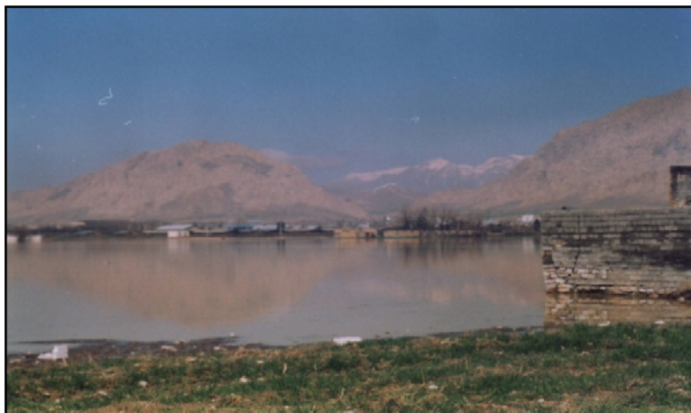
شکل ۳: پهنه‌های سیلابی ناشی از شیب معکوس اراضی بالادست جاده کمربندی کرمانشاه- اسلام‌آباد (سیلاب با دوره‌ی برگشت ده ساله) مأخذ: نگارندگان
