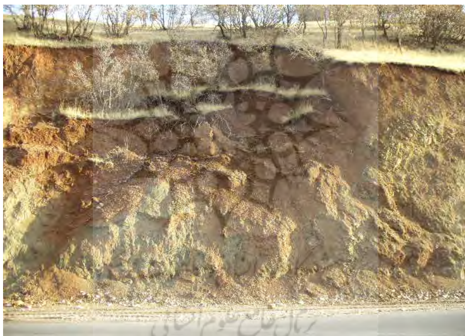
شکل ۱۲- نمونه‌ای از لغزش که در اثر زیر بری دامنه به وسیله احداث جاده صورت گرفته است
