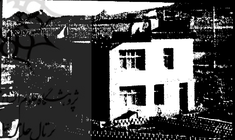
ساختمان اداری و حراست ترمینال شهرستان خاش
