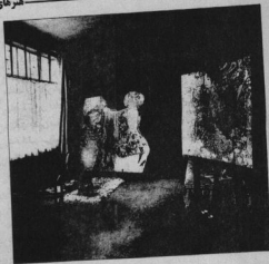
کارگاه نقاشی گوستاو کلیمت
