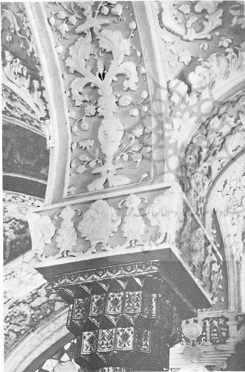
بخشی از گچ‌ریزهای سقف و ستون موزه
