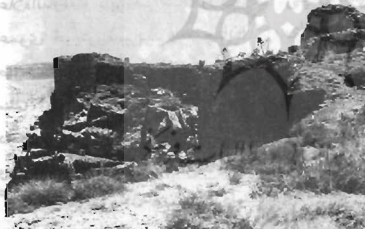
تصویر شماره (۶) - بخشی از برج و باروی قلعه در جبهه جنوبی
