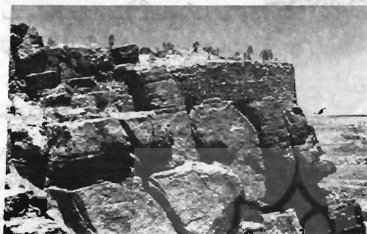
تصویر شماره (۳) - یکی از دیوارهای قابل نفوذ قلعه عماد در جبهه شرقی، مجاور مدخل قلعه
