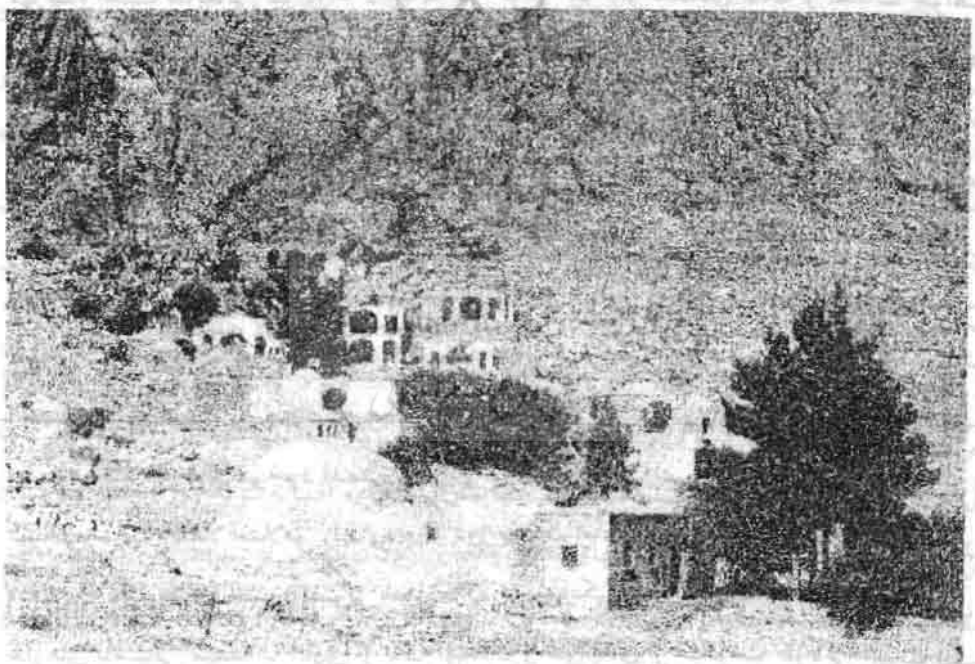
تصویر شماره ۲: دیواره گسل مشرف بر پیر نارکی مهریز احتمالاً بزرگترین زمین لغزه در تاریخ استان یزد در نزدیکی همین گسل روی داده است.
