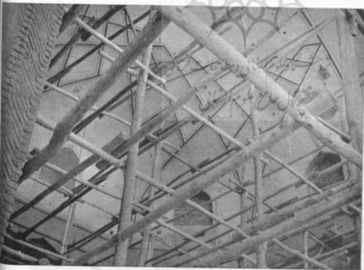
چوب بست ایوان و تصویر پرده بندیهای طاق آن از خلال تیرهای چوب بست دیده میشود
