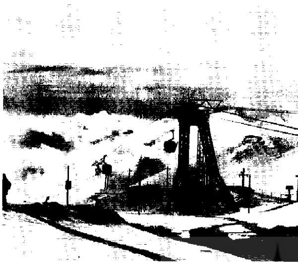
تله کابین گونه ای آسانسور هوایی است که از آن برای جابه جایی مردم یا کالا در مناطق کوهستانی استفاده می شود. تله کابین از یک حلقه ی طولانی کابل فولادی تشکیل شده که میان دو ایستگاه و دکل هایی میان آن دو ایستگاه، کابل را طی فاصله هایی نگه می دارند. در فاصله های مساوی، کابین هایی به کابل وصل می شوند و کابل توسط موتوری برقی در یکی از ایستگاه ها به حرکت در می آید. تله کابین در پیست های اسکی کاربرد زیادی دارد . [http://fa.wikipedia.org]
