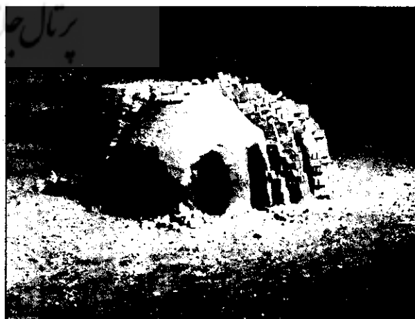
تصویر ۱۱: شکل روزنه‌های آتش و چیدمان خشت‌ها به دور آن در نمونه‌یی از کوره‌های آجرپزی منطقه خرامه - فارس
