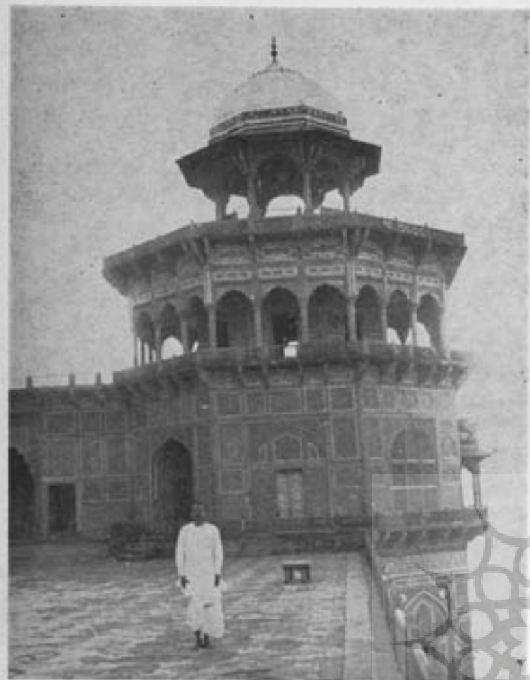
برج گوشه غربی
