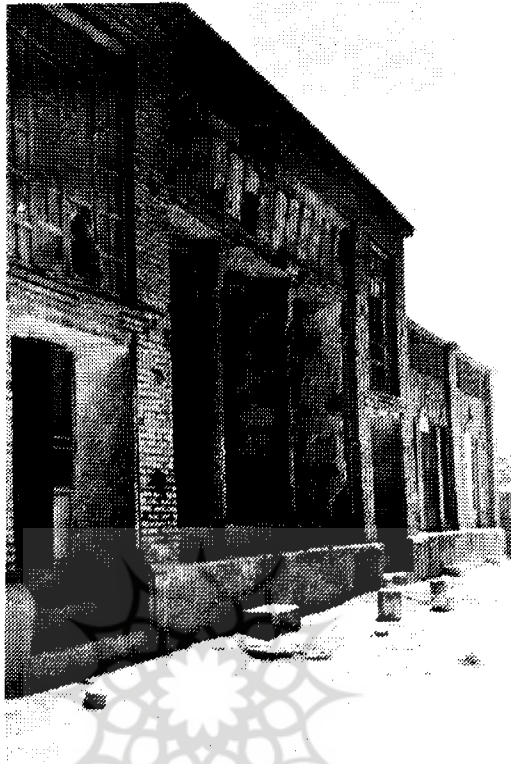
شکل ۴: عکس نمای جنوبی طبقه دوم عمارت بیرونی قلعه مستوفی الممالک.
