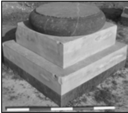
تصویر ۴. چگونگی شالوده سازی و استقرار پایه ستون در تالار مرکزی کاخ چرخاب. مأخذ: نگارندگان
