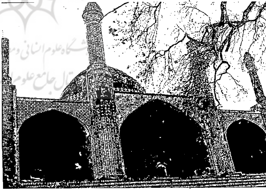
تصویر کنای ضلع غربی بنا با طاق های جناغی
