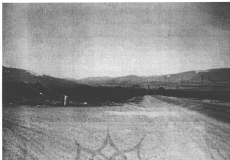
شکل شماره ۲۲. تصویر گلوگاه بزرسی و منطقه‌ی اطراف آن بعد از گردنه‌ی صلوات آباد در کیلومتر ۲۲ الی ۲۴ از مبدأ سنندج
