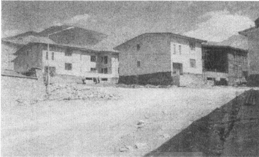
شکل ۲ ساخت خانه‌های مسکونی جدید در شهر باجگیران (گمرک)
