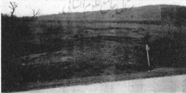
شکل ۱۳ عکس تغییر کاربری زمین از جنگل به زمین زراعی و احداث جاده در پای دامنه منجر به زمین لغزش در پیرانشیخ (محور پیرانشهر - سردشت) شده است.
