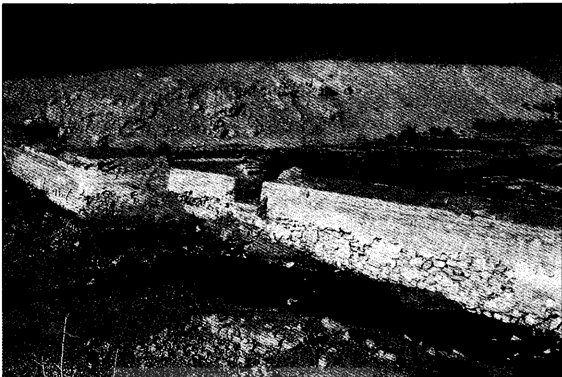
بند قدیم مروان، عریض‌ترین بند رودخانه که در حال حاضر با ایجاد سد رودشتین بدون استفاده مانده است.
