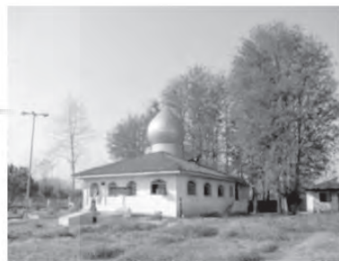
تصویر ۳۴- مسجد و مقبره آقا سید رضا واقع در روستای نخجیر کلابه لاهیجان. نصب گنبد فلزی بر روی بام سفالی.
