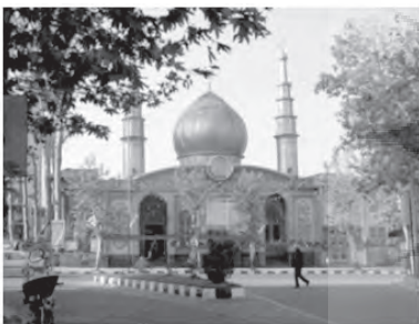
تصویر ۳۲- مسجد و مقبره آقا سید حسین واقع در لاهیجان که در طرح آن از گنبد ناری ویژه اقلیم گرم و خشک ایران استفاده شده است.
