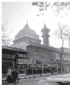
تصویر ۳۲- مسجد و مقبره آقا سید حسین واقع در لاهیجان که در طرح آن از گنبد ناری ویژه اقلیم گرم و خشک ایران استفاده شده است.
