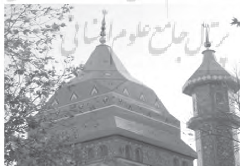
تصویر ۳۳- مقبره دو برادران آقا سید تقی و آقا سید ابراهیم واقع در روستای آهندان لاهیجان. گنبد و مناره‌های پیش ساخته بر روی سقف حلبی بنا نصب شده‌اند.
