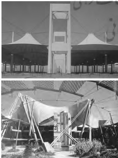
تصویر ۱ (بالا) - ایده‌ی فرم چادرهای صحرائشینیان، به جای استفاده از تنه درختان و پارچه، به وسیله‌ی کابل، فولاد و پوشش‌های تفلون در فرودگاه جده، احیا شده است، همین ایده در هتل و مرکز همایش مکه (تصویر ۲، پایین) نیز دنبال شده است.
