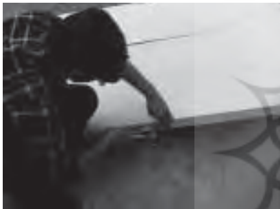
پر کردن محل قفل و دستگیره در به منظور جایگزینی آن با دستگیره و قفل سنتی
