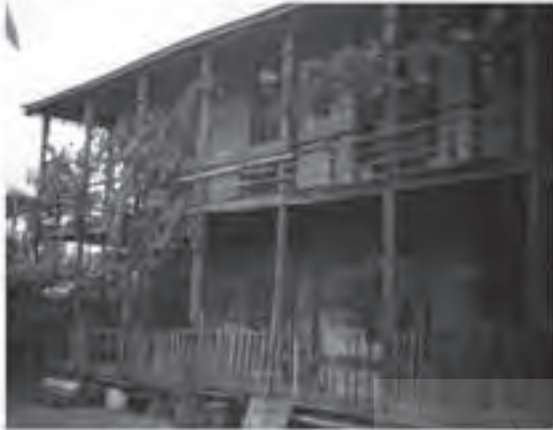
تصویر ۲. بنای دو طبقه
