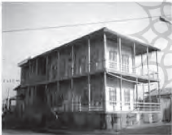
تصویر ۴. بنای سه طبقه
