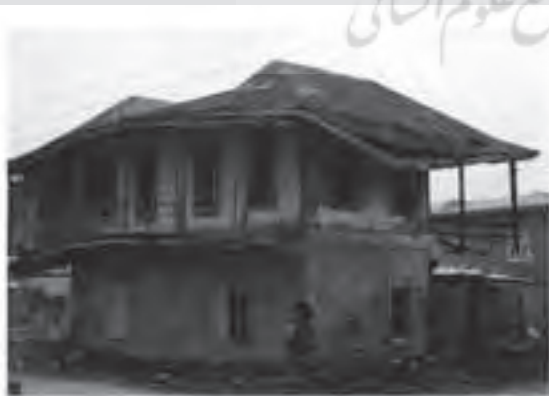
تصویر ۱۵. نمونه‌ای از خانه‌ی قدیمی در حال تخریب
