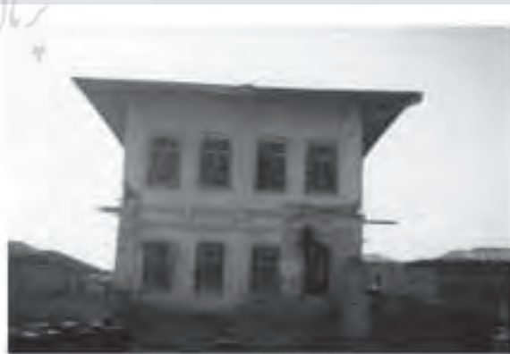
تصویر ۱۴. نمونه‌ای از خانه‌ی قدیمی در حال تخریب
