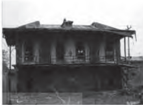
تصویر ۱. بنای دو طبقه
