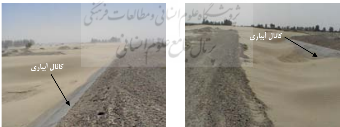
شکل ۳. پر شدن کانال‌های آبیاری سیمانی به طول چندین کیلومتر که بر اثر انباشت شن و ماسه غیرقابل استفاده شده‌اند
