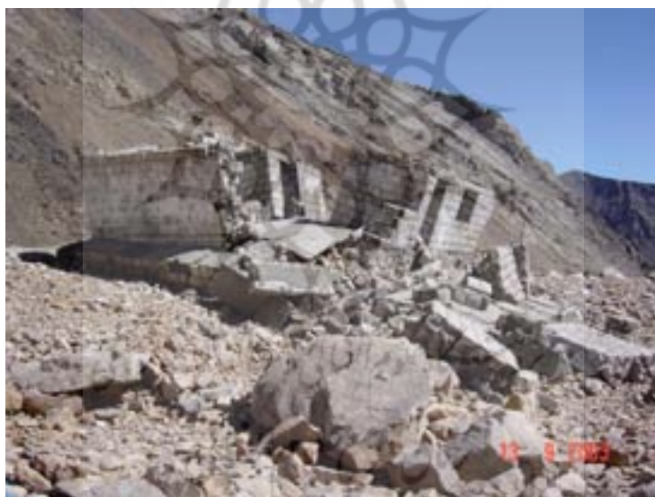
شکل ۲۴. تخریب مجدد ضلع جنوبی پناهگاه علم‌چال در اثر تداوم حرکت یخچالی این عکس در سال ۱۳۸۲ گرفته شده است.
