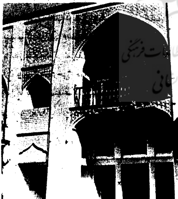
عکس شماره ۴۳- خانه داوید اصفهان شکست درگاه بالائی به علت استفاده از کلیل در دهانه پائین
