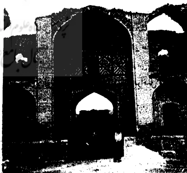
عکس شماره ۴۲- کاروانسرای مرنجاب کاشان شکست چند بخصوص در ناحیه تیزه
