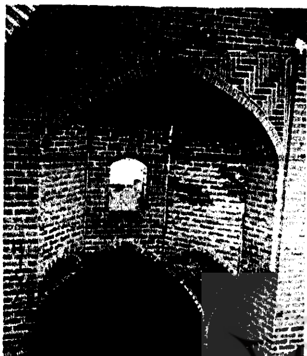
عکس شماره ۴۱- آب انباری در یزد استفاده از چند غلط و شکست آن در ناحیه ایوارگاه
