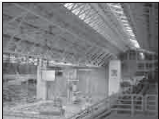
سازه به کار رفته در سقف استخر شنا
