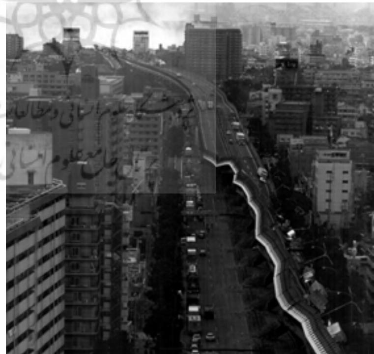
متفاوت به سختی صدمه دیده زیرا پایه ها منهدم شده است و بزرگراه «هانشین» باید به اندازه ۱۰ کیلومتر کاملاً منهدم و مجدداً ساخته شود.
