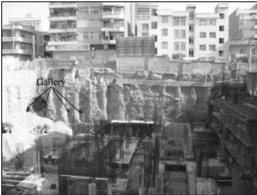
شکل شماره ۲- پی کنی ساختمان و قطع گالری چهار کاریز توسط آن در شهر تهران، گالری قطع شده سوم دارای آبدهی اندک می‌باشد که در آینده احتمالا مشکل آفرین خواهد شد. نگاه عکس به شمال می‌باشد.
