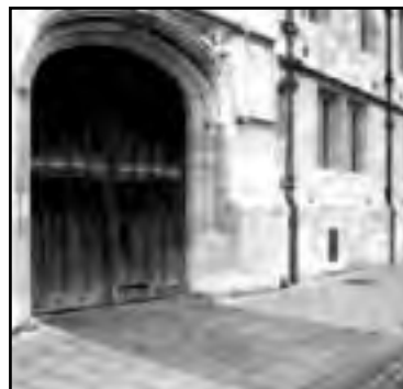
آستانه در ورودی ماشین رو یک ساختمان
