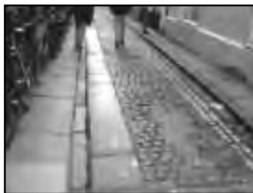
جدولها و کانالهای گرانیتی، به همراه قلوه سنگ و ماسه سنگ کار گذاشته شده در کف کوچه
