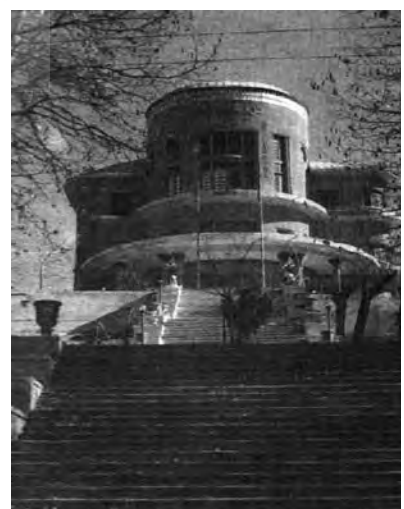
تصویر ۱۳ - هتل آبعلی، اکسپرسیونیسم فرمالیستی. (ماخذ: آرشیو بهروز پاکدامن)
