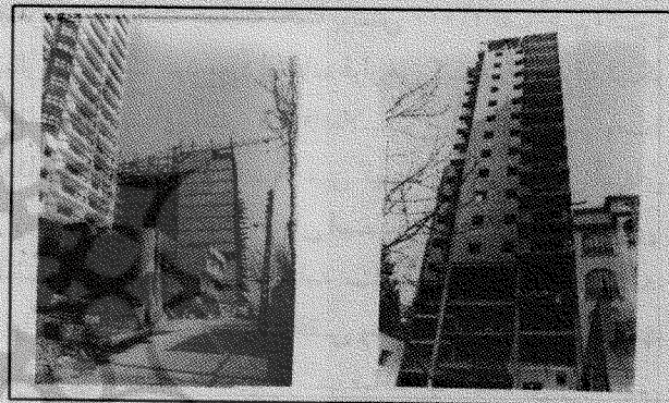
شکل شماره ۶ و ۷: ساختمانهای بلند در حال ساخت (الهیه)
