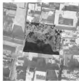
خانه تخریب شده در عکس ۱۳۸۱
