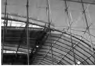
تصویر شماره ۲۰- عناصر کششی و فشاری نگهدارنده شیشه هادر ترمینال بین المللی واترلو در شهر لندن
