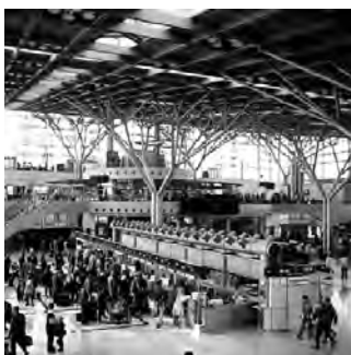
تصویر شماره ۲۳ - فرودگاه اشتوتگارت، طراحی شده توسط فون گرکان
