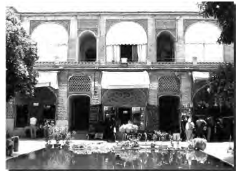
۱۲ - تقارن، نظم، ریتم، وحدت، انسجام، هماهنگی، تناسبات، مقیاس، ترکیب، و استحکام بصری همگی در این بدنه مصداق دارند.
