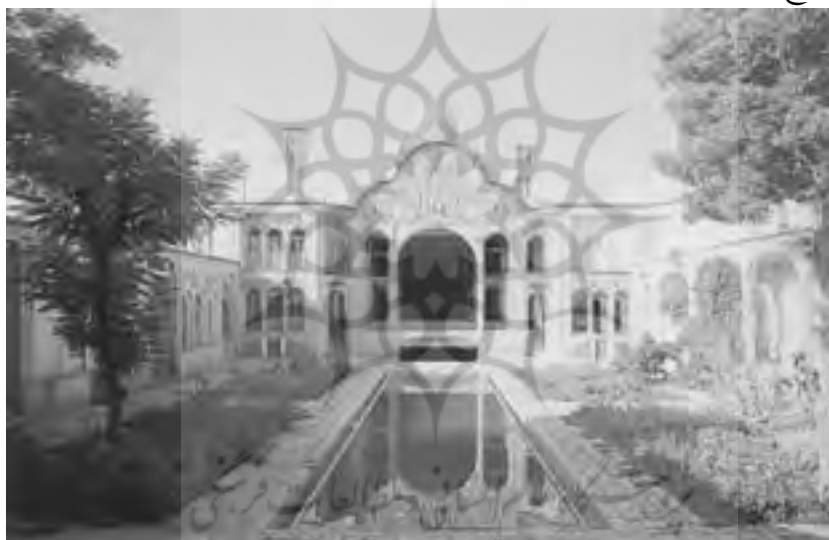
شکل شماره (۱) جبهه شمالی خانه بروجردی‌ها، استفاده از حیاط مرکزی برای تهیه ریززیست‌اقلیم خاص و نیز استفاده از جریان باد بادگیرها برای خنک سازی محیط حیاط که دریچه‌های آن در دو گوشه جبهه شمالی بر روی سطح زمین مشاهده می‌شود. (منبع: گنجنامه، ۱۳۷۵: ۴۲)
