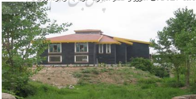
عکس ۳: نمایی از ساختمان کتابخانه مجازی روستای قرن‌آباد
