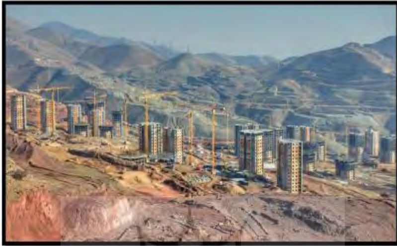
شکل 8. نمایی از بلوک‌های مسکونی 15 طبقه در فاز 11 شهر جدید پردیس 1
