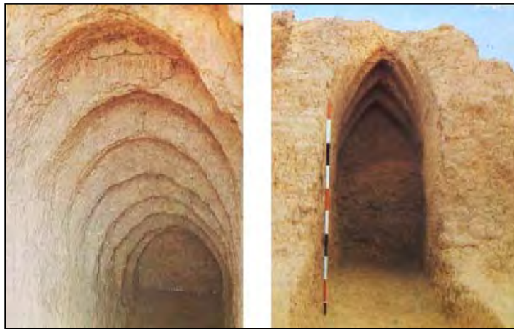
شکل ۲-۶-۱. جزئیات تاق‌های پلکانی با قوس‌های مدور در محوطه IV (چپ) و (VI (راست) (هرمان ۱۳۷۳: ۳۷).
